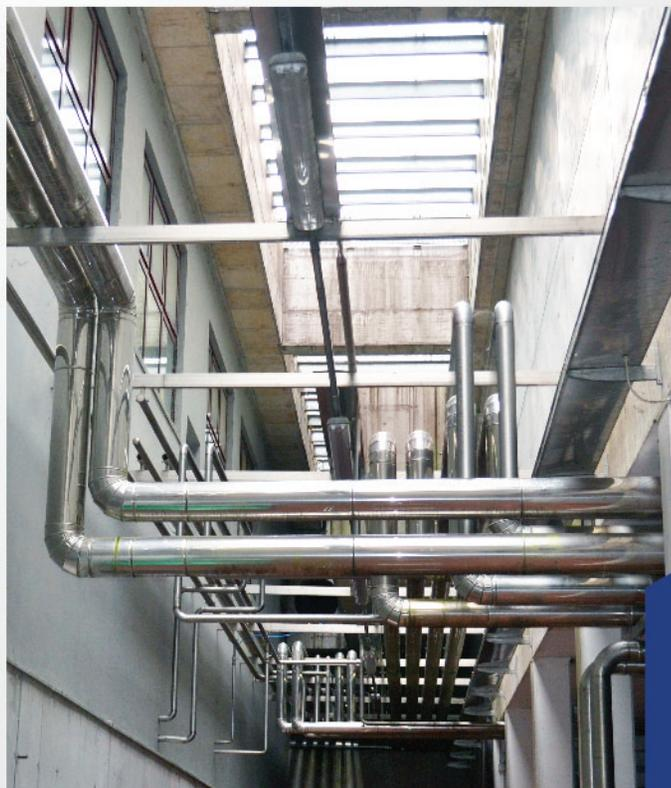
Casagrande realizza tubazioni in acciaio inox di varie tipologie: per trasporto vapore, liquidi per termocondizionamento e liquidi oleosi.
